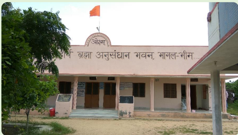
महर्षि ब्रह्मा अनुसंधान भवन
